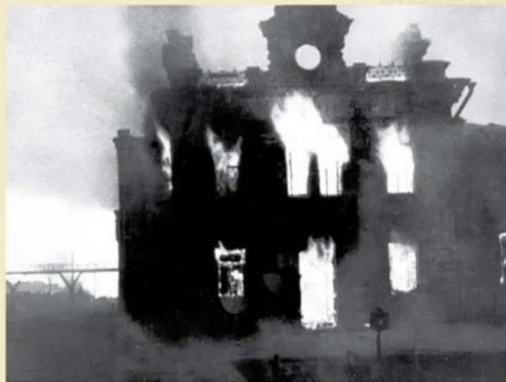
\\ 23 августа 1942 года. Горящее здание вокзала Сталинград-1
